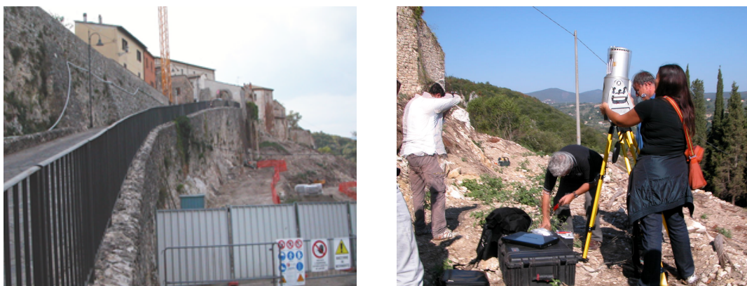
Figura 1.29 - Cantiere nell'area della Zona D (foto del 12-09-2012) e rilievo del 18-09-2012
