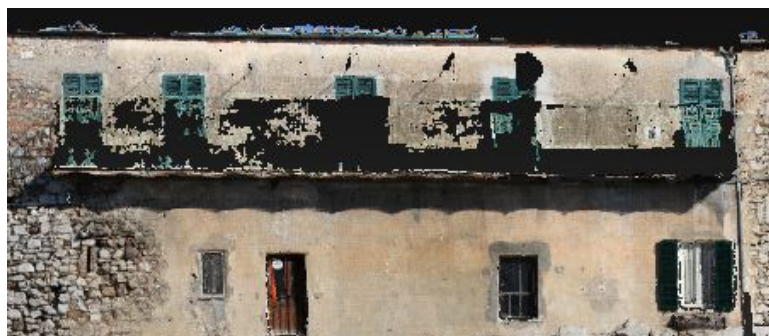
Figura 5.44 - Lacune nella ricostruzione per la presenza di elementi sottili e traforati
