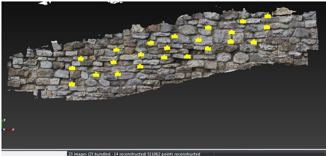
Figura 5.24 - Set 2: ricostruzione di un tratto di mura della scalinata verso Porta Stufi
