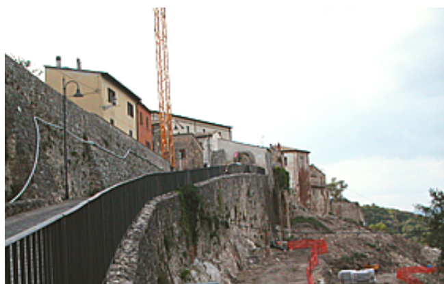
Figura 1.20 - Zona D - vista da Via delle Mura è attualmente area di cantiere.
