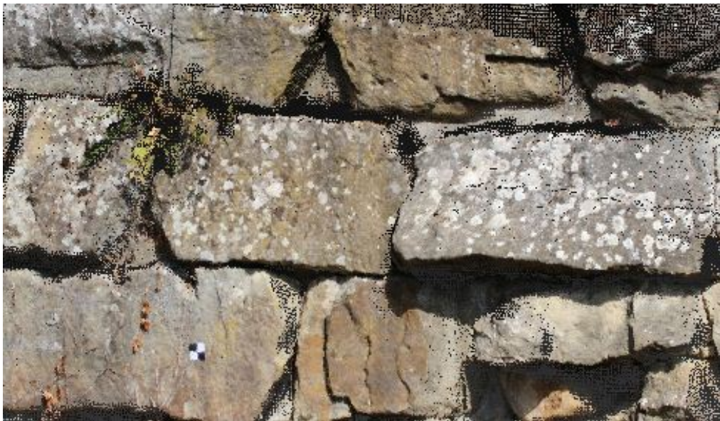
Figura 6.30 - Dettaglio ingrandito della nuvola. Notare l'importanza dell'RGB originario.
